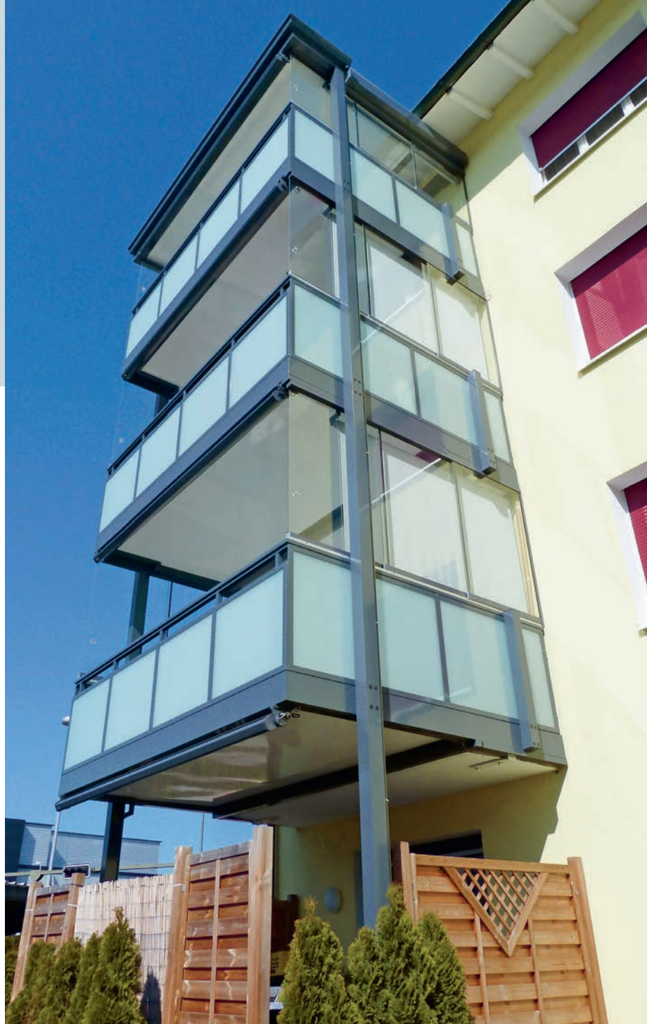
Balkonverglasungen schützen vor Wind und Wetter. Eine allseitig umlaufende Verglasung bietet zusätzlichen Schutz vor Lärm.
