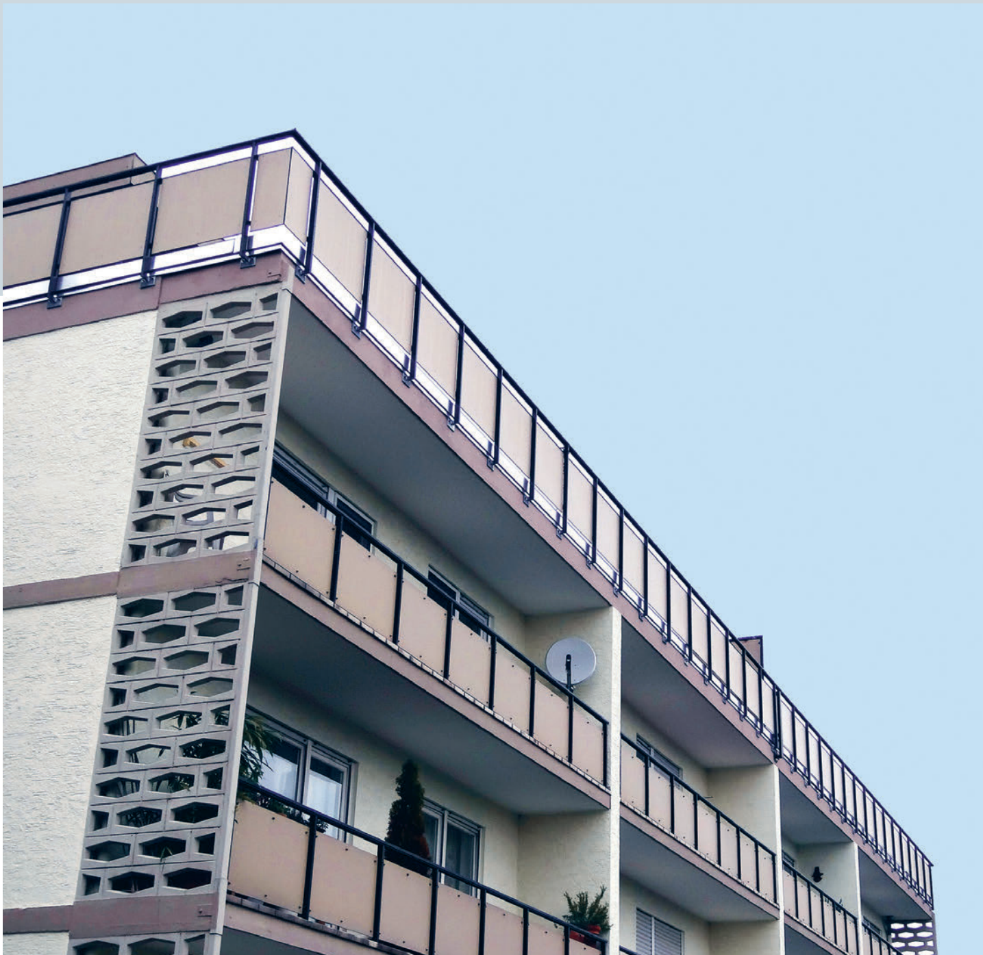
An der Rückseite des Hauses beträgt die Länge des Aluminiumgeländers 34 m. Ursprünglich war keine funktionierende Bewegungsfuge vorhanden. La balustrade en aluminium avait une longueur de 34 m à l'arrière de la maison. À l'origine, aucun joint de dilatation n'était opérationnel.
